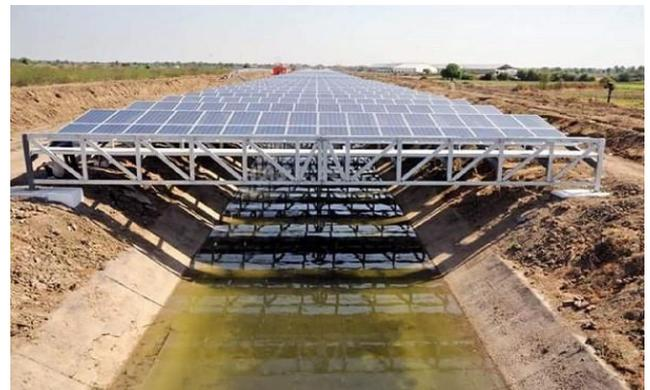
شکل ۵: نمونه‌ای از قرار گرفتن پنل‌های خورشیدی روی کانال آب
