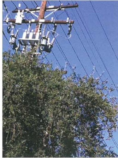
شکل ۸۷ - خازن‌هایی که روی شبکه توزیع هوایی نصب شده‌اند. (منبع: Esri، عکاس: بیل میهان)
