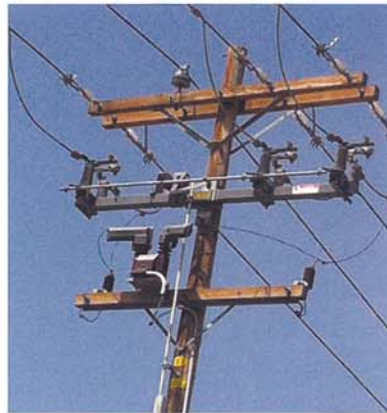
شکل ۷-۱۱- یک نمونه کلید جداساز سه فاز (عکاس: Zackary Johnson، منبع: Esri)
