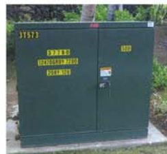
شکل ۷-۹- تابلوی پدمانند حاوی ترانسفورماتور روغنی سه فاز (عکاس: بیل میهان، منبع: Esri)
