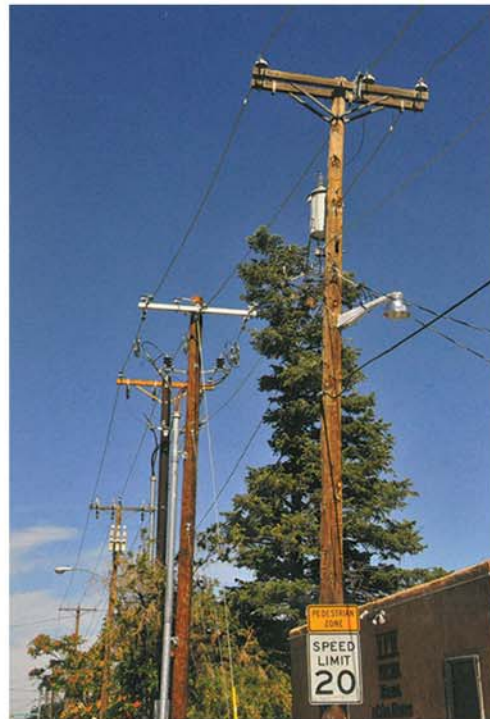
شکل ۷-۴ - فیدر فشار متوسط هوایی (عکاس: Zackary Johnson، منبع: Esri)
