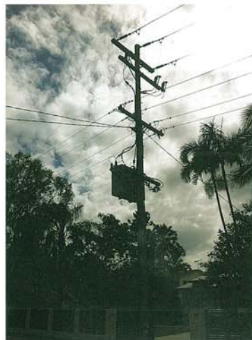
شکل ۹-۴- آرایش‌های مختلف کراس آرم بر روی پایه (منبع: Esri، عکاس: بیل میهان)
