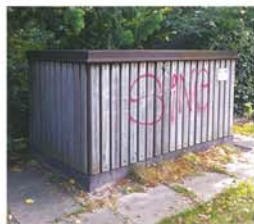
شکل ۷-۱۰- یک نمونه پست MV/LV سطحی (عکاس: بیل میهان، منبع: Esri)
