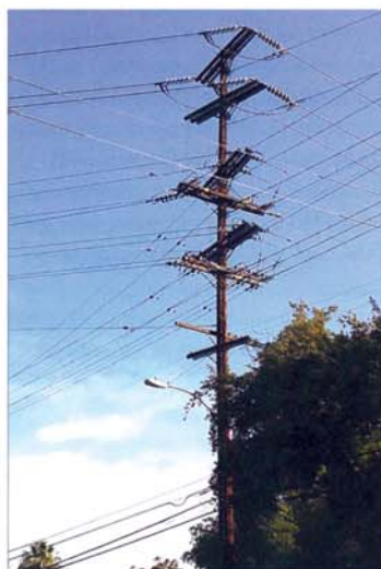
شکل ۴-۱- عبور هم‌زمان شبکه فشار متوسط و فشار ضعیف بر روی یک پایه مشترک (عکاس: بیل میهان، منبع: Esri)
