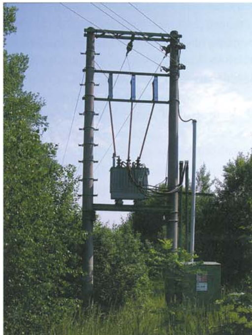
شکل ۹-۱- یک پست هوایی MV/LV نصب شده بر روی پایه (منبع: شرکت توزیع CEZ)
