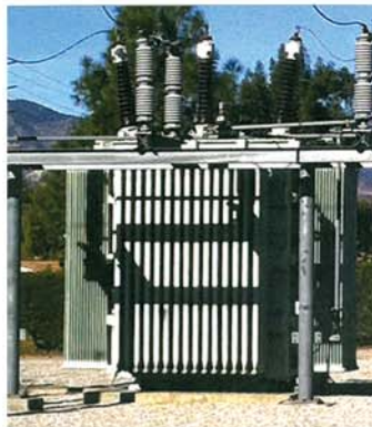
شکل ۶-۶ - یک نمونه ترانسفورماتور پست فوق توزیع با سیستم خنک‌کنندگی تکمیلی (عکاس: بیل میهان، منبع: Esri)
