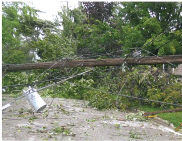
شکل ۷-۲- خسارت دیدن شبکه هوایی در اثر طوفان (عکاس: Zackary Johnson منبع: Esri)
