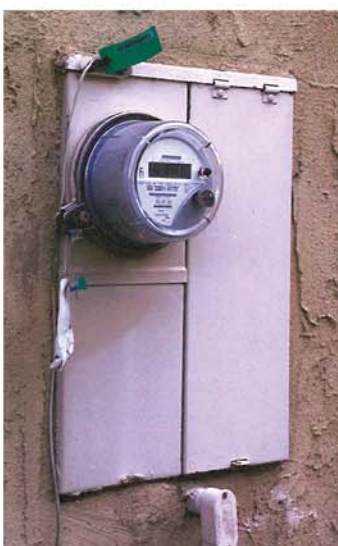
شکل ۲-۹- یک نمونه کنتور هوشمند (عکاس: بیل میهان، منبع: Esri)
